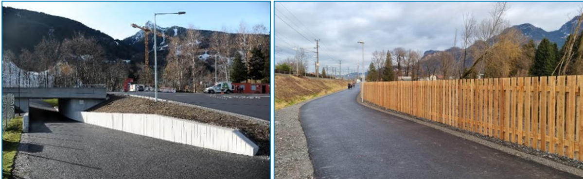
Abbildung 10 Links: Radunterführung L188 in Schruns; Rechts: Radschnellverbindung Klienstraße in Hohenems
