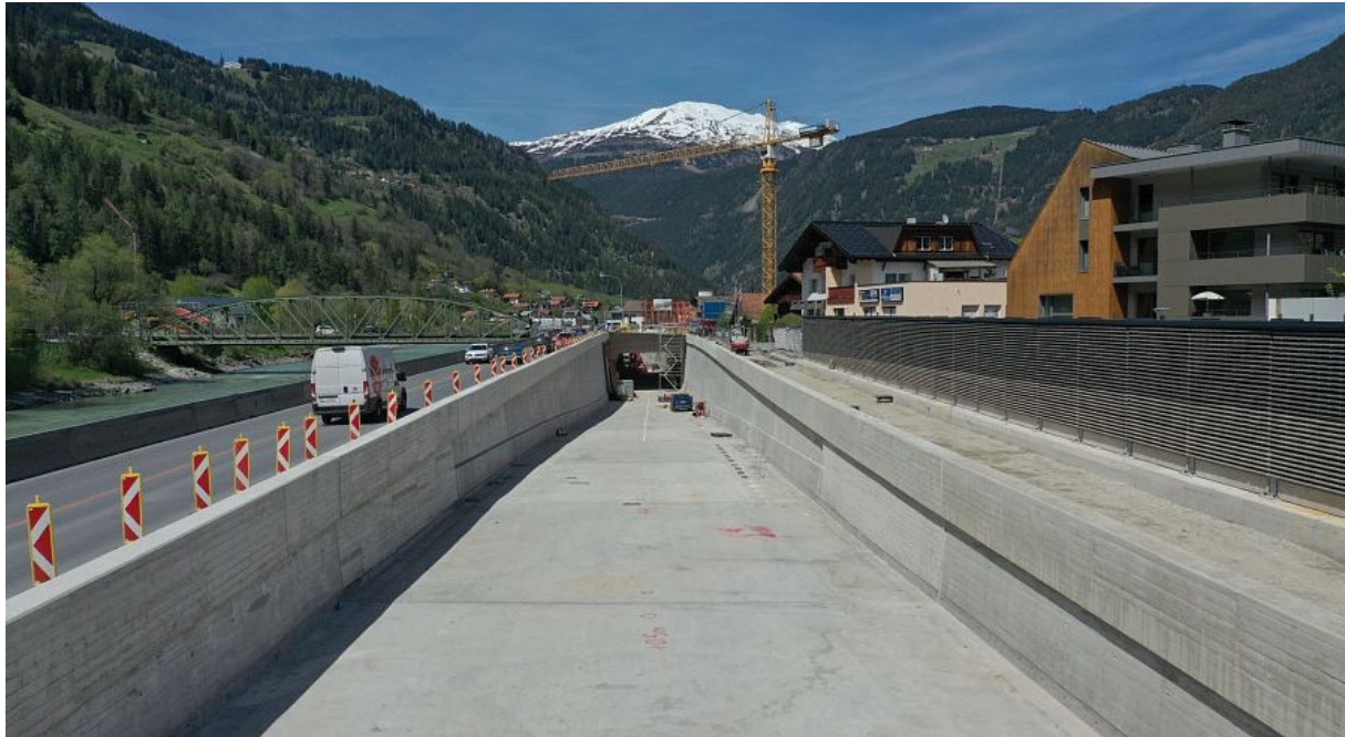
Abbildung 12: Unterführung der Reschenstraße in Prutz
