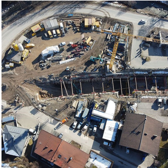
Abbildung 7: Baufortschritt der Unterflurtrasse der Loferer Straße
