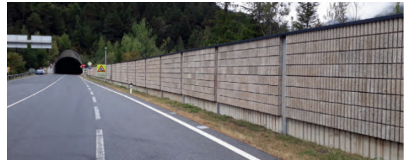
Abbildung 9: Lärmschutzwand NACH der Ertüchtigung (Holzbeton)
