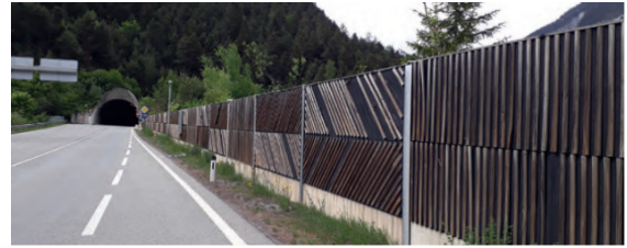
Abbildung 9: Lärmschutzwand NACH der Ertüchtigung (Holzbeton)
