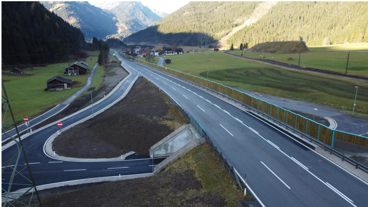
Abbildung 10: Fernpassstraße bei Lähn/Wengle, Umbaumaßnahmen samt Lärmschutzwand
